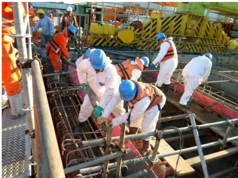
**Figura 5.23** Execução de concretagem de vigas.
