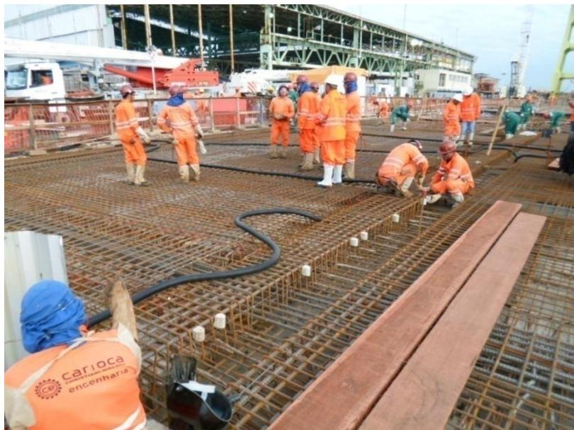
**Figura 5.46**Armação da Laje in loco.
