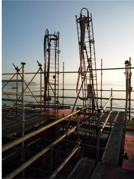
**Figura 5.41** Colocação de armações para estacas metálicas.
