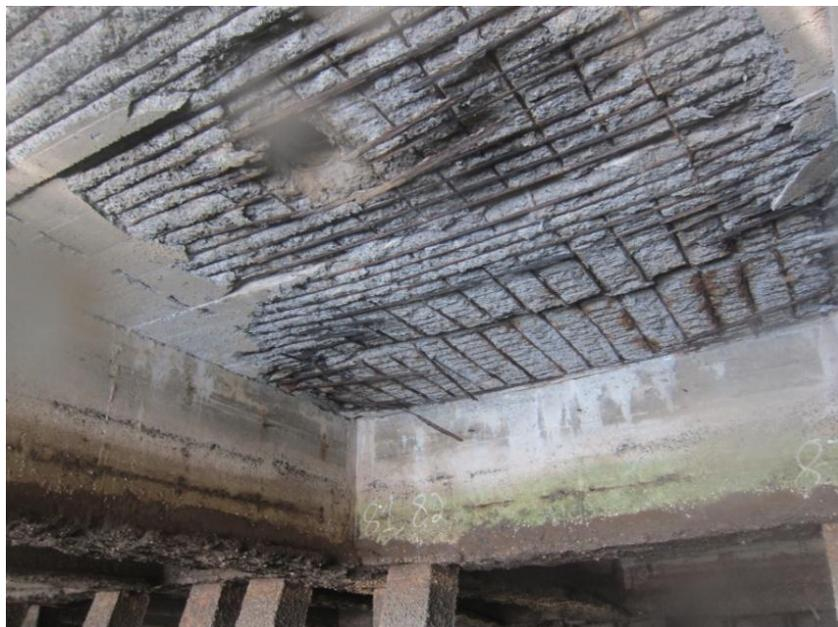
**Figura 5.2 Deslocamento do concreto de cobrimento.**
