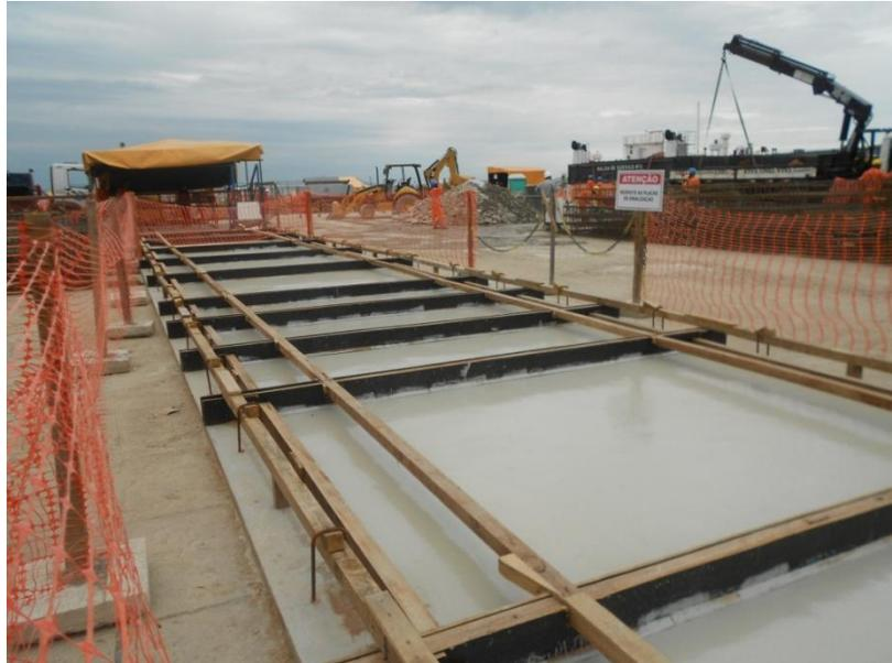
**Figura 5.14** Berço utilizado na concretagem de pré lajes na central de pré moldados
