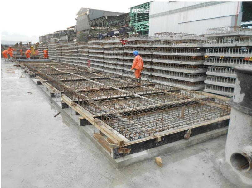
**Figura 5.17**Armazenamento de pré lajes concretadas
