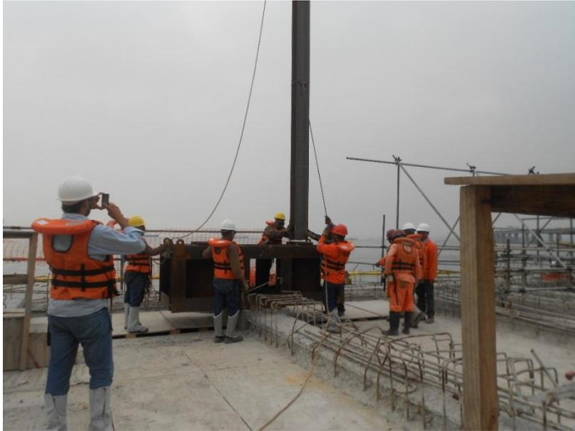
**Figura 5.35** Alinhamento das estacas com gabarito metálico.
