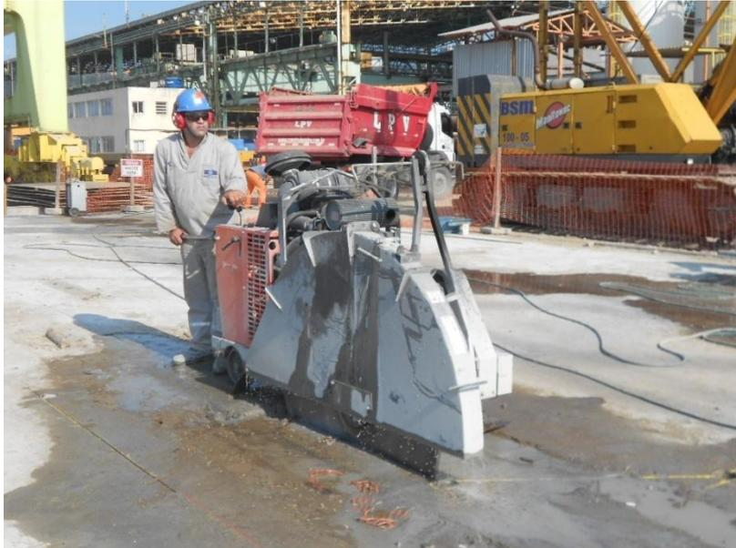
**Figura 5.5 Corte da Laje .**
