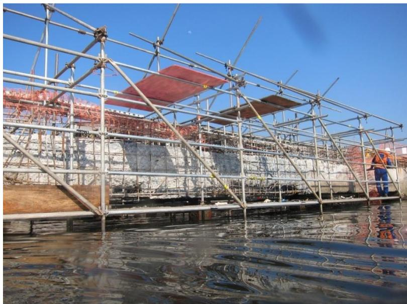
**Figura 5.28**Detalhe da estrutura provisória montada na viga de paramento.
