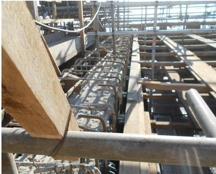
**Figura 5.22** Execução de forma e escoramento para concretagem de vigas.
