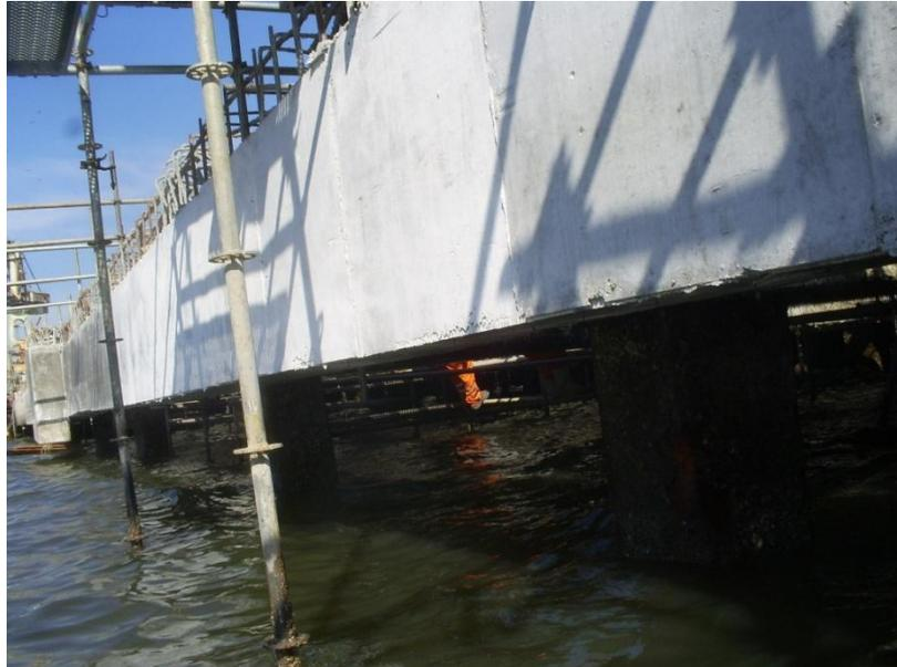
**Figura 5.29**Viga de paramento e base da defesa concretada.
