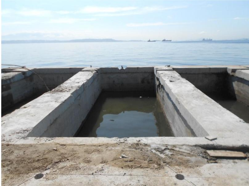
**Figura 5.9** Vista da estrutura do cais depois da retirada da laje.
