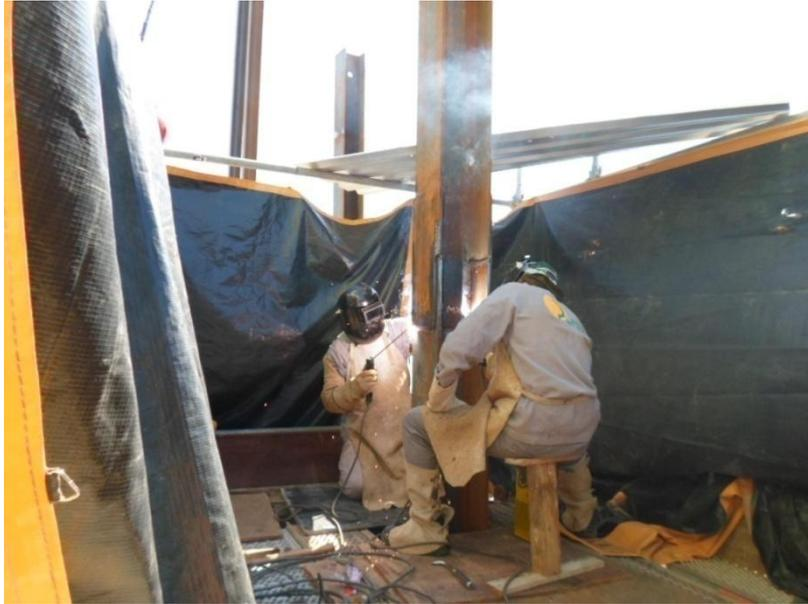
**Figura 5.37**Execução de eventuais solda de perfis metálicos.
