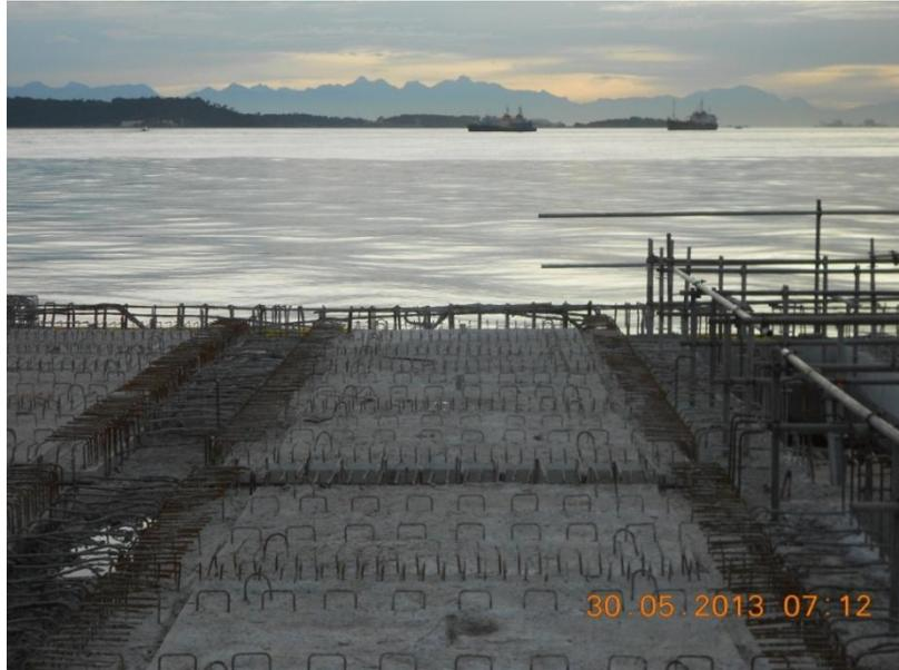
**Figura 5.45**Pré lajes posicionadas.
