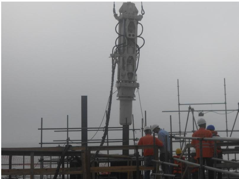
**Figura 5.36** Cravação das estacas metálicas.
