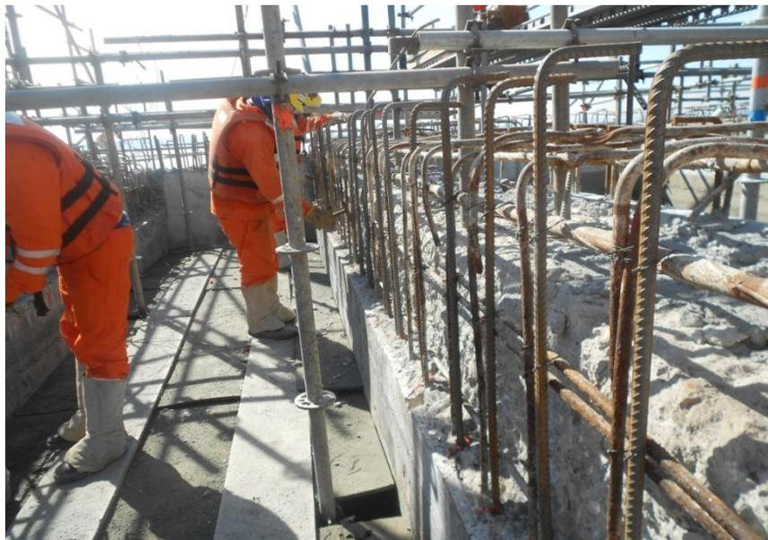
**Figura 5.21**Execução de substituição de armadura.
