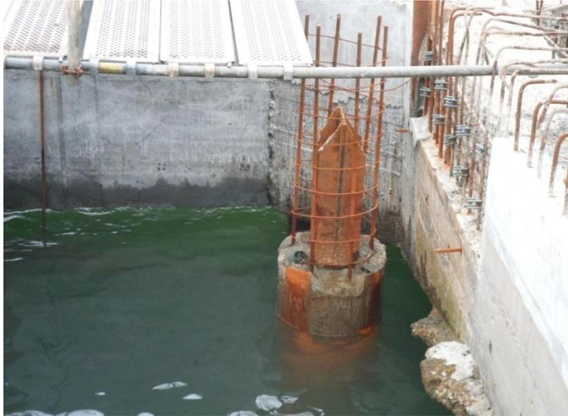
**Figura 5.43**Corte e arrasamento de estacas metálicas.
