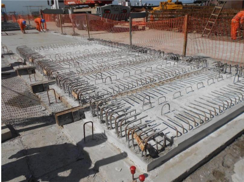
**Figura 5.16**Pré lajes concretadas
