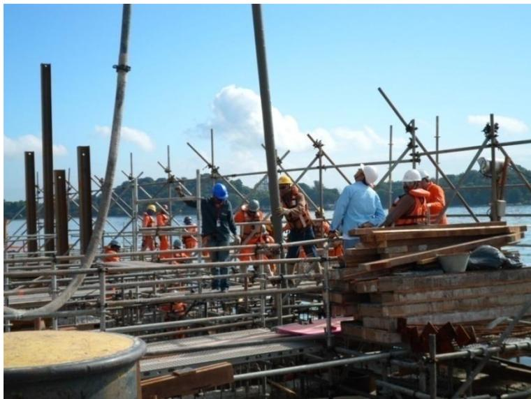
**Figura 5.42** Concretagem das estacas metálicas.
