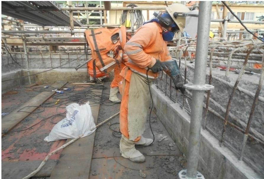
**Figura 5.20**Execução de furos no concreto das vigas para substituição de armadura.
