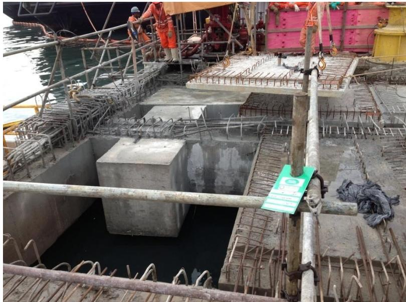
**Figura 5.44**Posicionamento das pré lajes e blocos de coroamentos.
