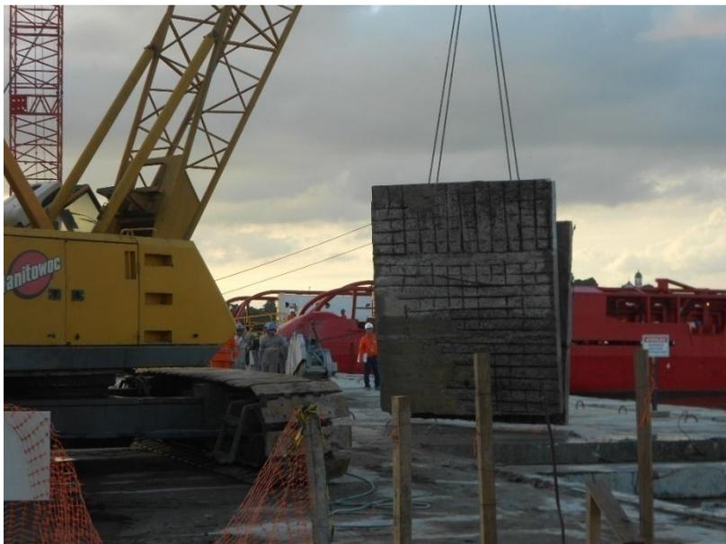
**Figura 5.6 Retirada da laje utilizando guindaste**
