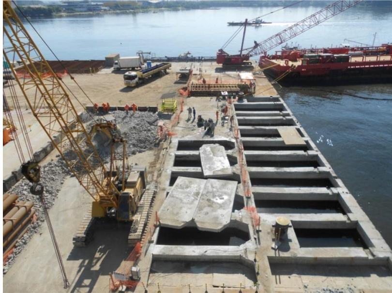
**Figura 5.7 Lajes retiradas**
