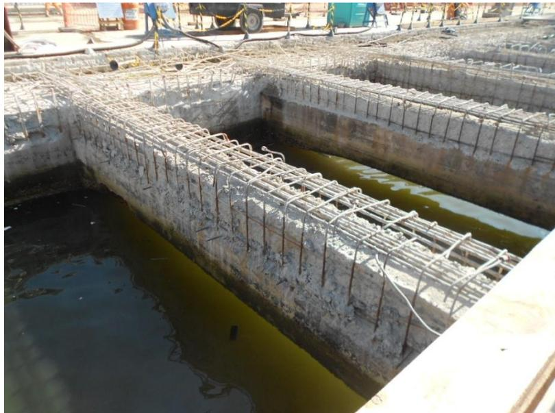
Figura 5.19 Vigas internas escarificadas, prontas para troca de aço.
