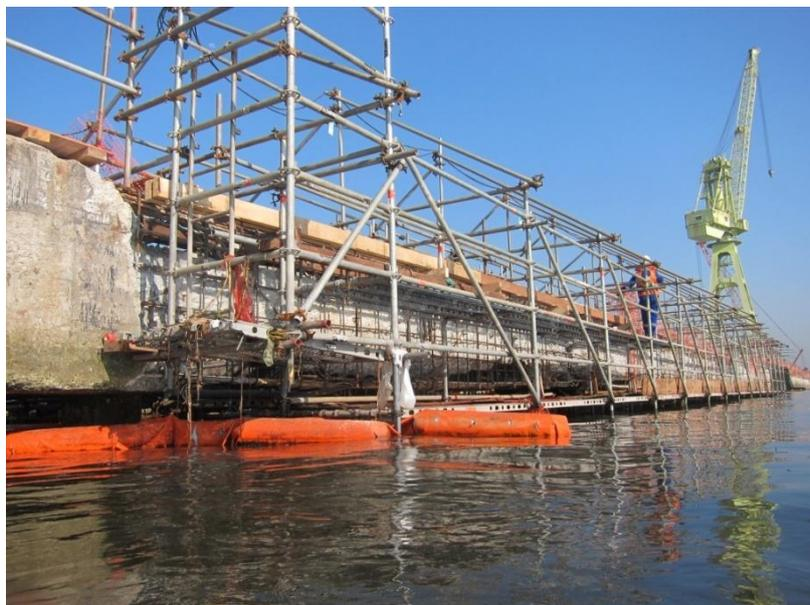
**Figura 5.27**Viga de paramento escarificada.
