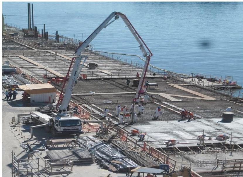
**Figura 5.48** Vista geral da execução da laje final (in loco).
