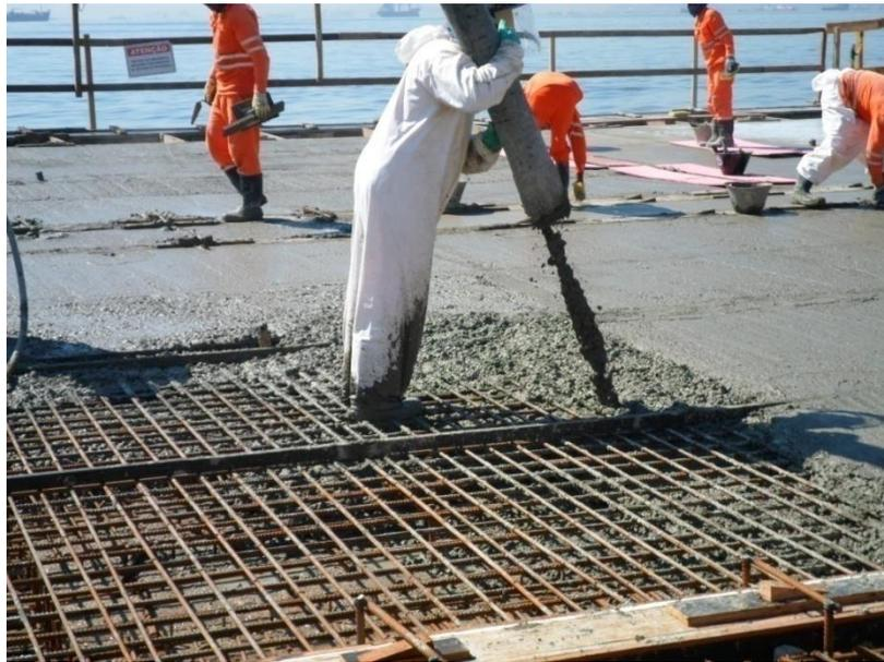
**Figura 5.47** Concretagem da laje final (in loco).
