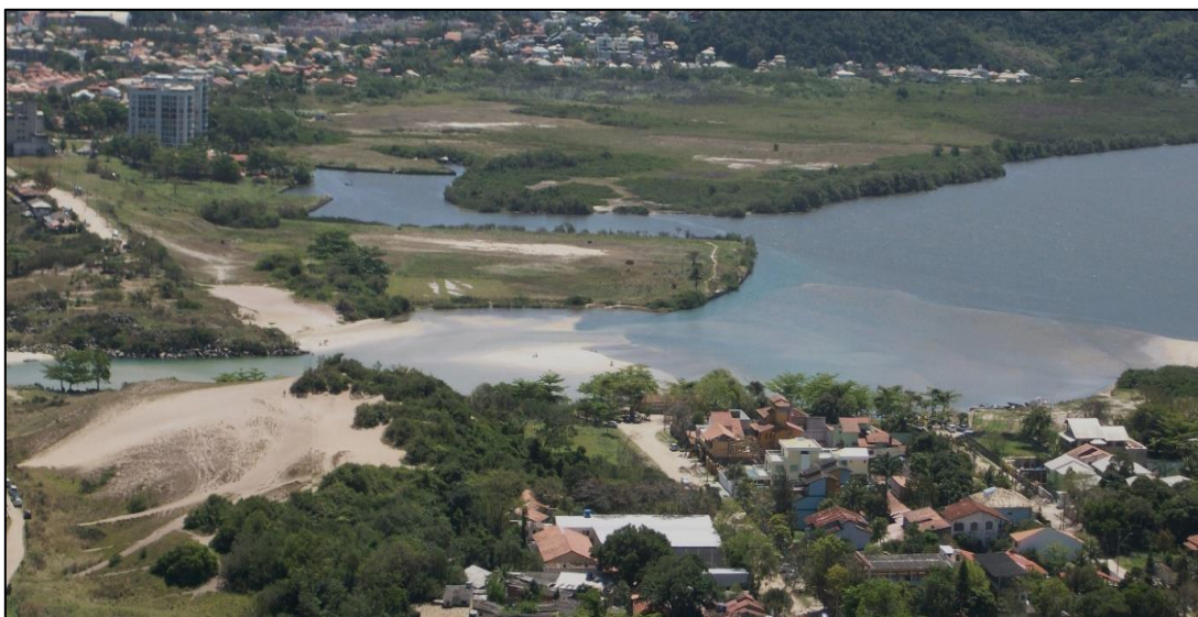
Figura 8: Assoreamento na desembocadura do Canal de Itaipu na Lagoa de Itaipu. Foto tirada em setembro de 2013.
