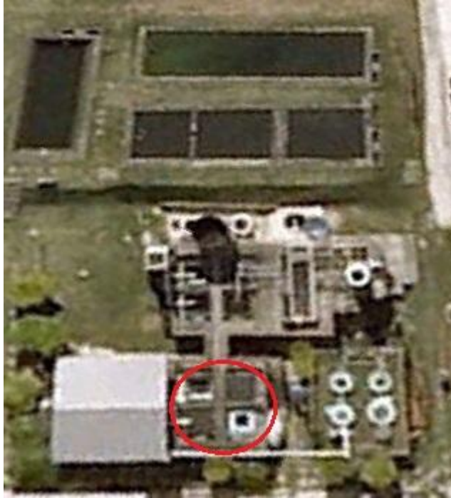
Figura 7 – Vista aérea da área dos decantadores primários
