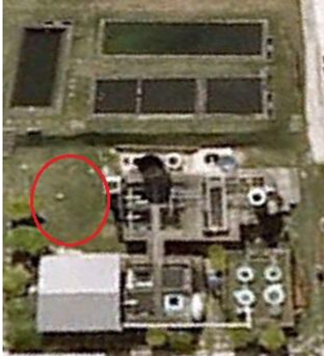
Figura 8 – Vista aérea com marcação da alternativa 2
