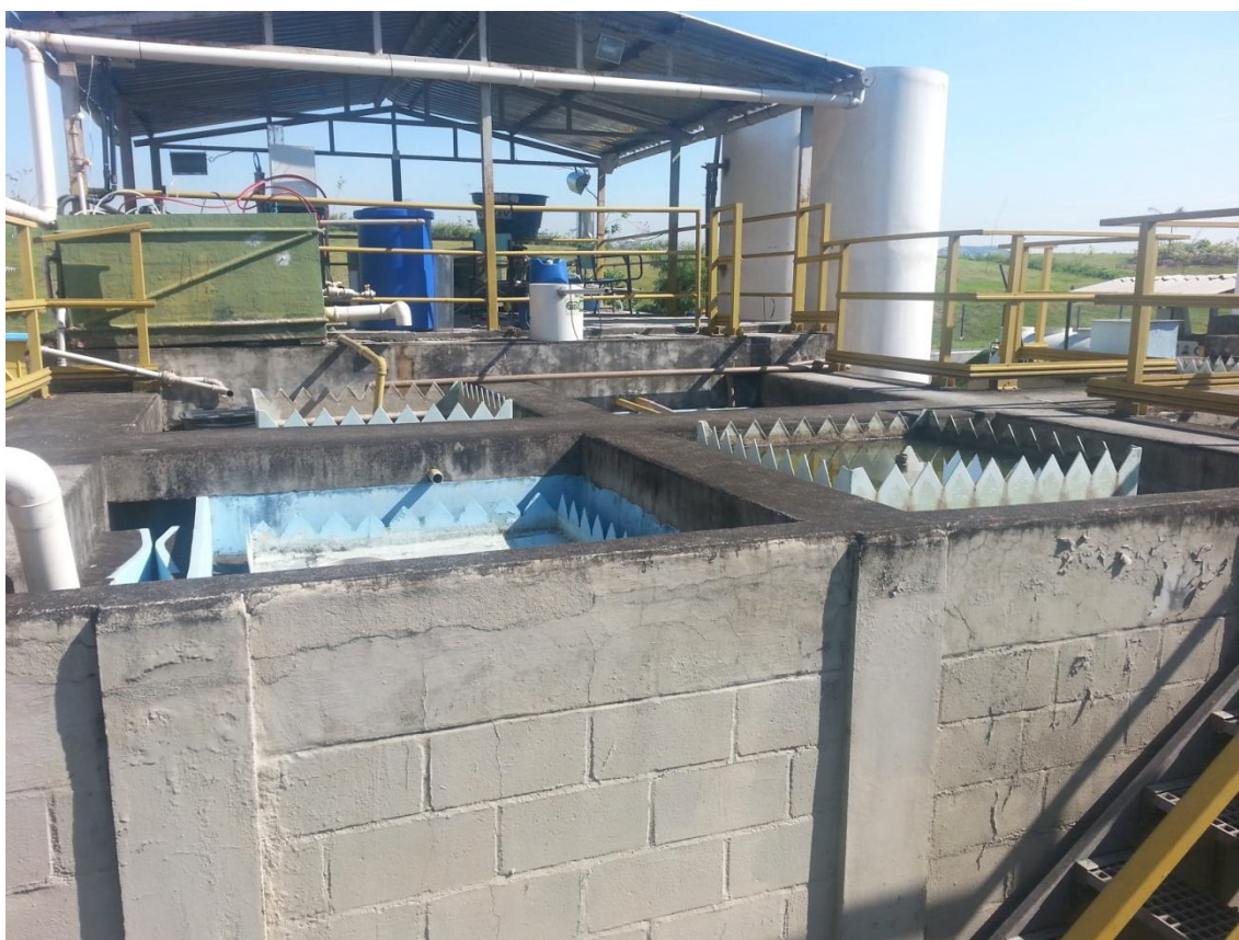
Figura 6 – Fotografia dos decantadores primários
