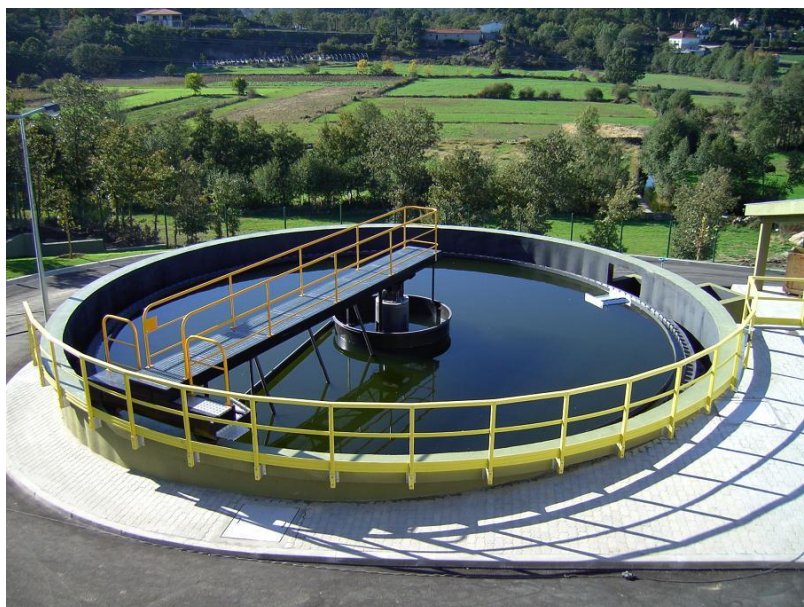
Figura 9: foto de um decantador secundário com sensor e raspador de espuma
