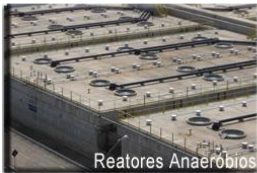
Figura 2: Reatores Anaeróbios da ETE Onça – Belo Horizonte
