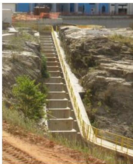
Figura 12: Escada de peixe em construção Fonte: Autoria própria (20/03/2012)
