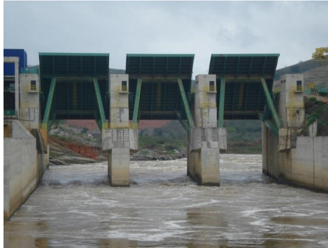
Figura 11: Vertedouro com três comportas tipo segmento Fonte: Autoria própria (01/11/2010)
