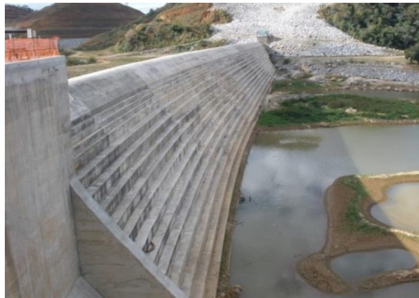
Figura 10: Vista da barragem já concluída
