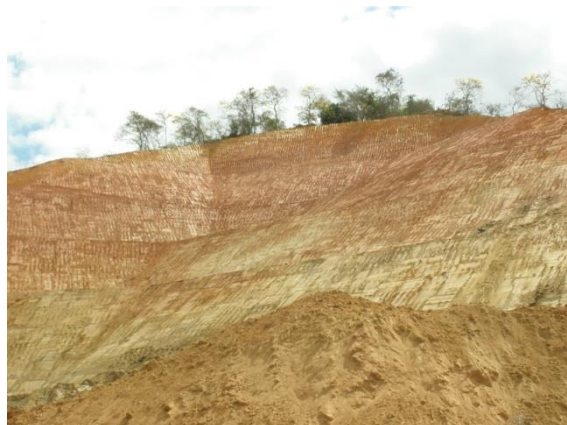
Figura 19: Retaludamento de encosta em Simplício
