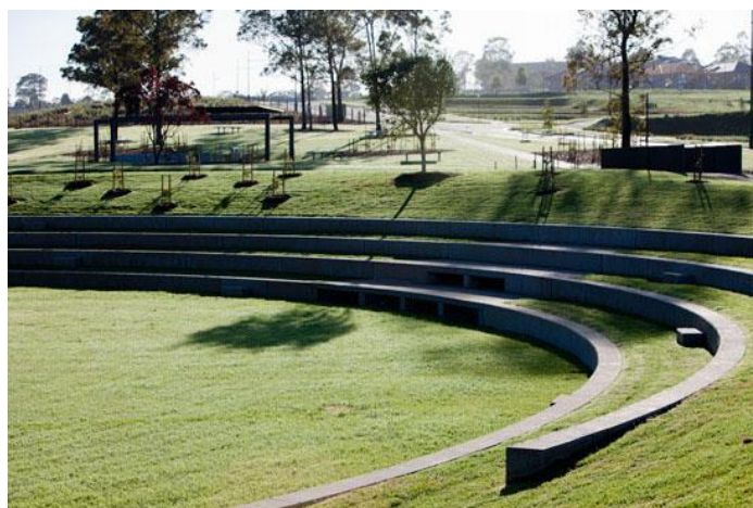
Figura 15 - Exemplo de bacia de retenção off-line bem integrada com a paisagem.
