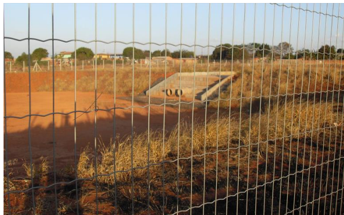
Figura 14 – Exemplo de reservatório sem a preocupação com a estética.
