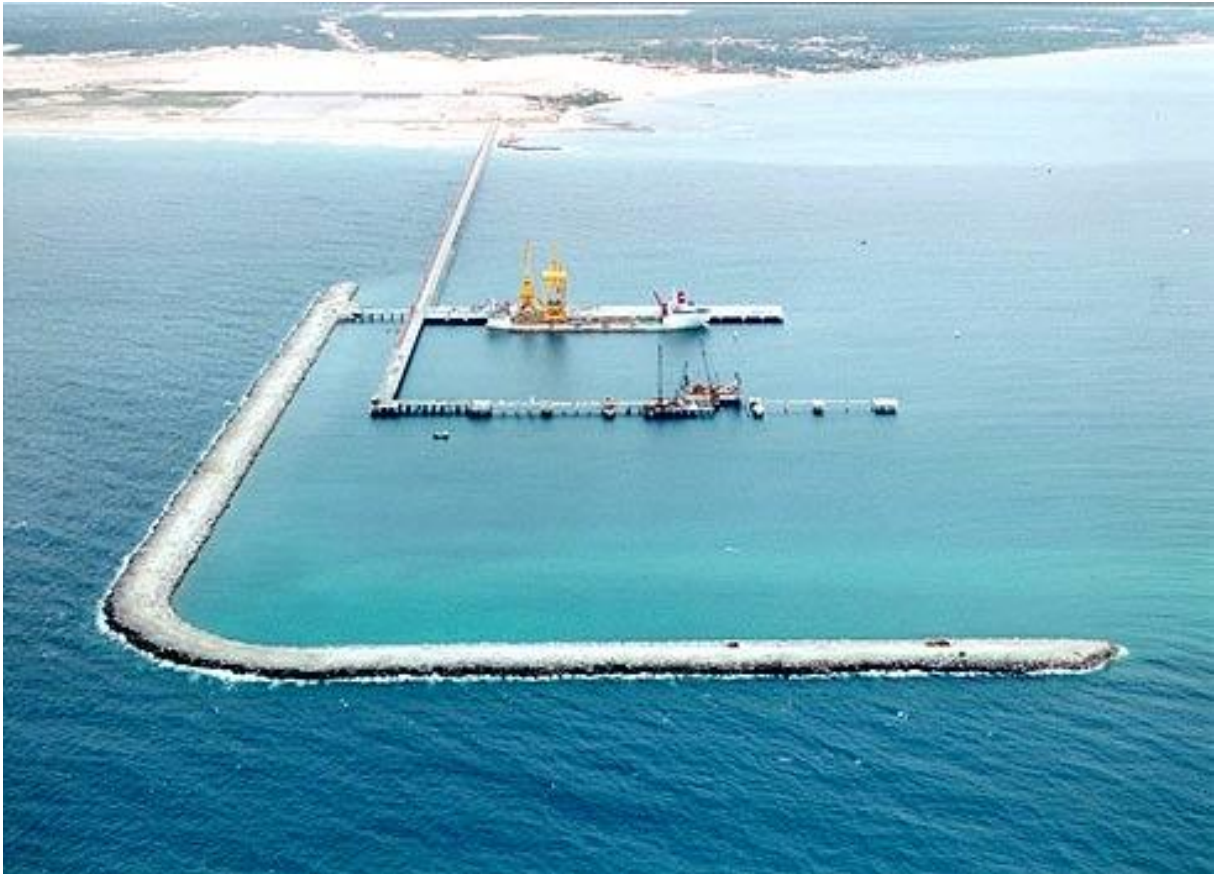
Figura 3 - Quebra-mar localizado no Porto de Pecém (CE) Fonte: Apolo11 (2010)
