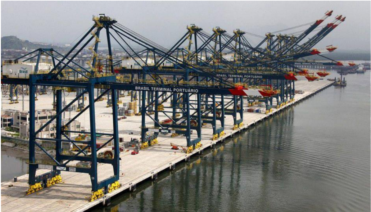
Figura 5 – Portêiner (ou Ship-to-Shore Crane ) do tipo Super-Post-Panamax no terminal de contêineres da BTP em Santos(SP) Fonte: BTP (2013)
