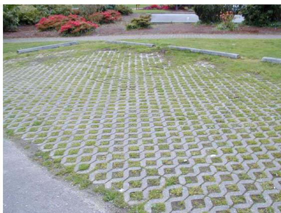
**Figura 7 – Exemplo de aplicação de pavimento permeável**
