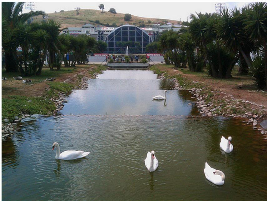
**Figura 12 – Escada hidráulica para dissipação de energia com projeto paisagístico**
