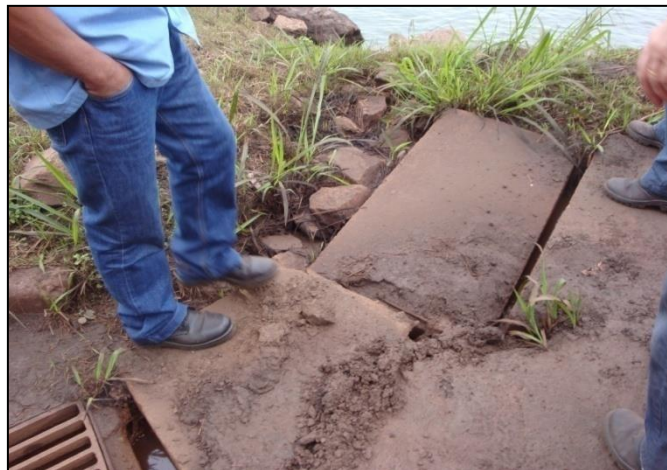
Figura 24: Local de encontro da drenagem de água pluvial com o mar. Verificação de um caminho preferencial para o mar (Fonte: Projeto Resíduos Portuários, 2012)
