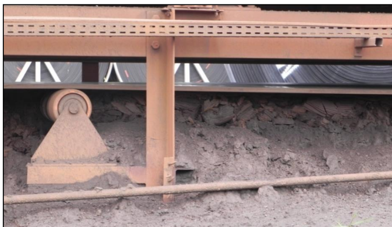
Figura 19: Acúmulo de graneis sólidos abaixo das correias transportadoras. (Fonte: Projeto Resíduos Portuários, 2012)
