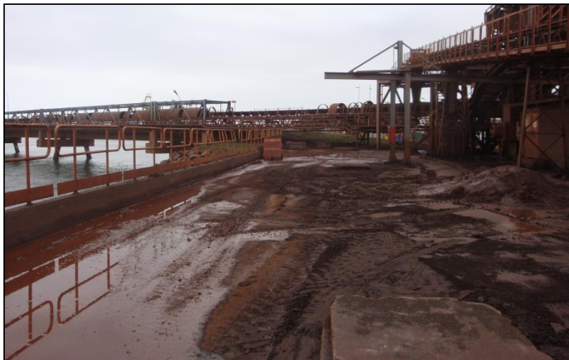
Figura 22: Poças de água no píer, na lateral das correias transportadoras. (Fonte: Projeto Resíduos Portuários, 2012)
