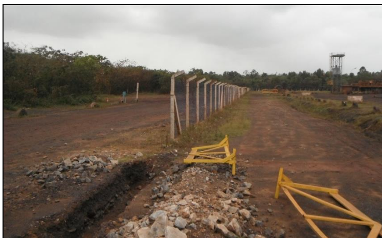
Figura 25: Rua ao lado do pátio de minério sem drenagem adequada (Fonte: Projeto Resíduos Portuários, 2012)
