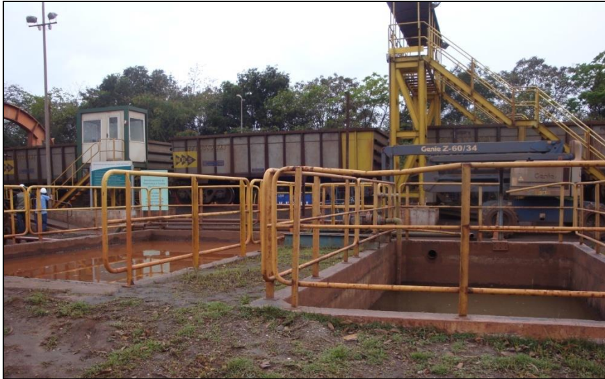
Figura 36: Tanque de decantação e sequência de tratamento da água de lavagem do virador de vagões. (Fonte: Projeto Resíduos Portuários, 2012)
