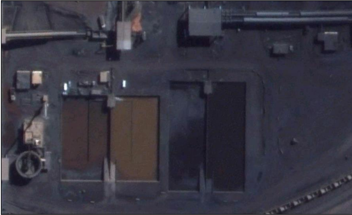
Figura 41: Imagem do sistema de tratamento de água do terminal – tanques de decantação, unidade físico-química e tanques de armazenagem do efluente já tratado. (Fonte: GoogleEarth, 2012)
