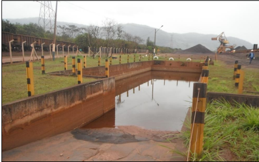
Figura 33: Tanque Sul do Terminal VALE. (Fonte: Projeto Resíduos Portuários, 2012)
