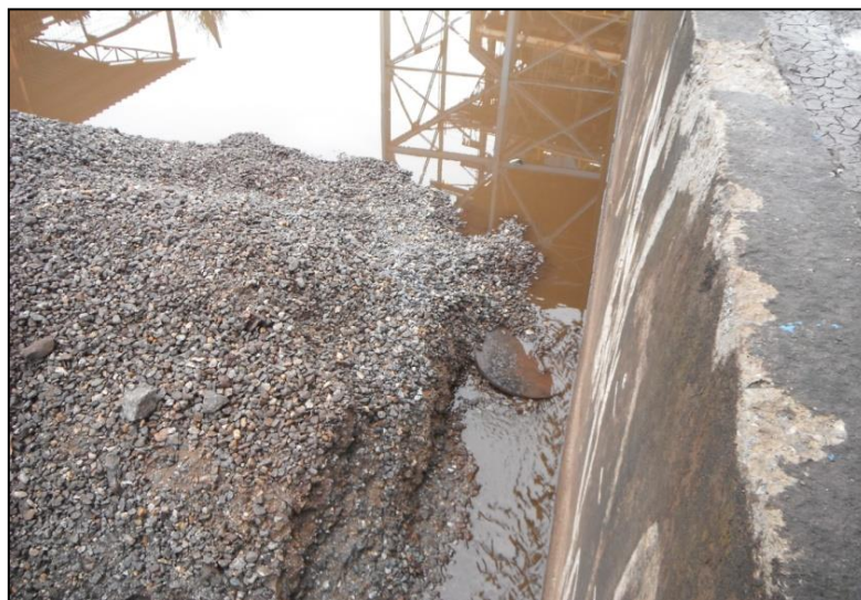
Figura 29: Caminho preferencial formado na lateral do filtro de brita. (Fonte: Projeto Resíduos Portuários, 2012)
