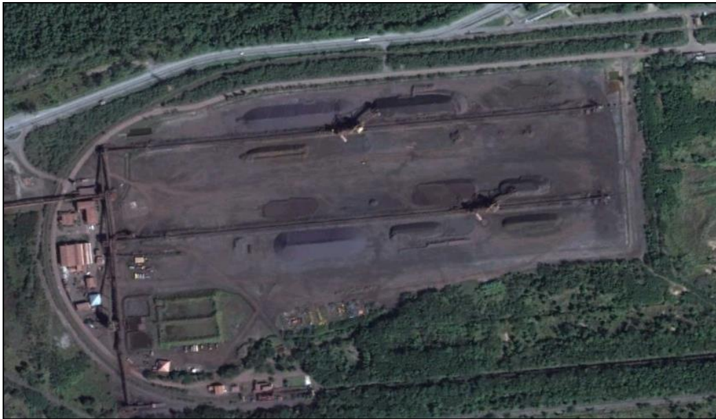
Figura 16: Foto aérea terminal VALE (Fonte: GoogleEarth, 2012)
