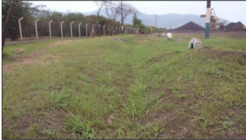
Figura 21: Calhas assoreadas e com vegetação crescendo. (Fonte: Projeto Resíduos Portuários, 2012)
