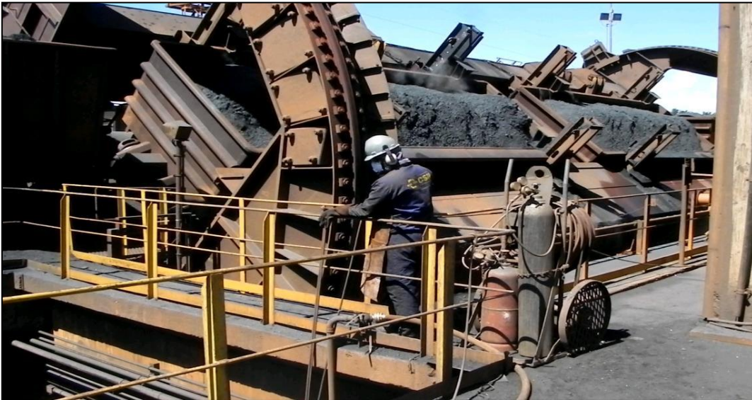
Figura 2: Operação do virador de vagões (Fonte: Projeto Resíduos Portuários, 2012)
