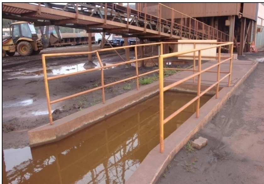
Figura 37: Tanque de decantação localizado no píer do terminal VALE (Fonte: Projeto Resíduos Portuários, 2012)
