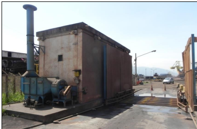
Figura 47: Lavador de pneus do terminal CSN e equipamento para reuso da água (Fonte: Projeto Resíduos Portuários, 2012)
