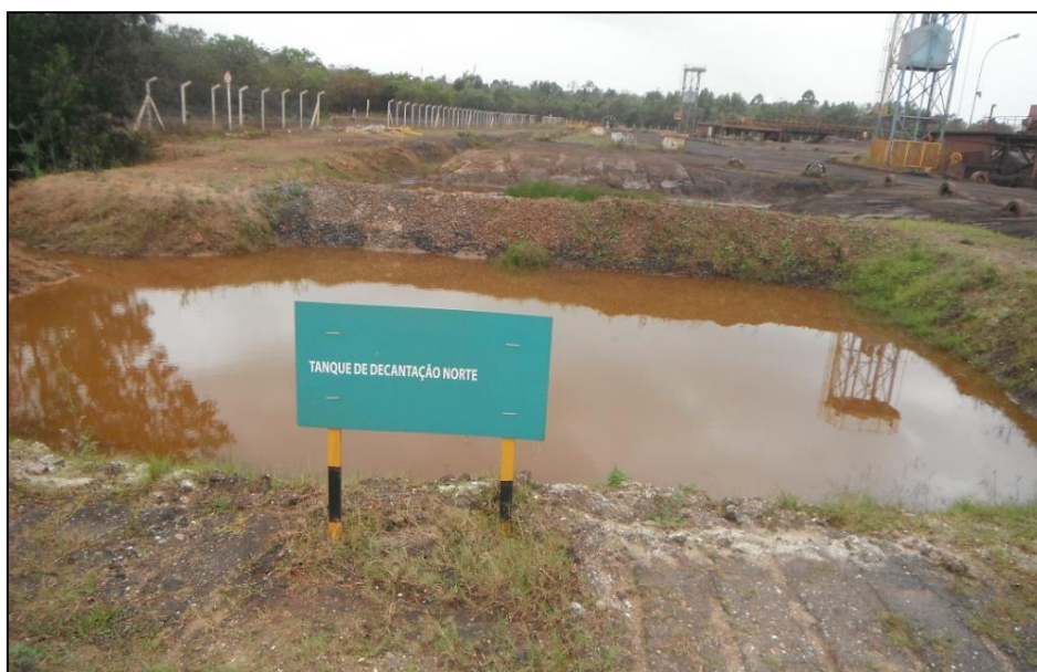
Figura 34: Tanque Norte de decantação. (Fonte: Projeto Resíduos Portuários, 2012)
