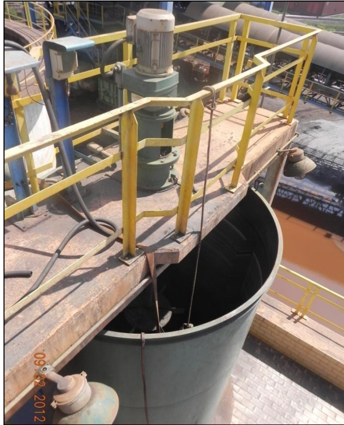
Figura 43: Centrifugador da ETE, onde há coagulação dos sólidos no efluente. (Fonte: Projeto Resíduos Portuários, 2012)
