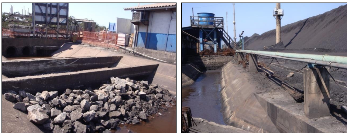
Figura 48: Descarte Leste, de águas pluviais e calha de drenagem pluvial, do pátio do terminal CSN. (Fonte: Projeto Resíduos Portuários, 2012)
