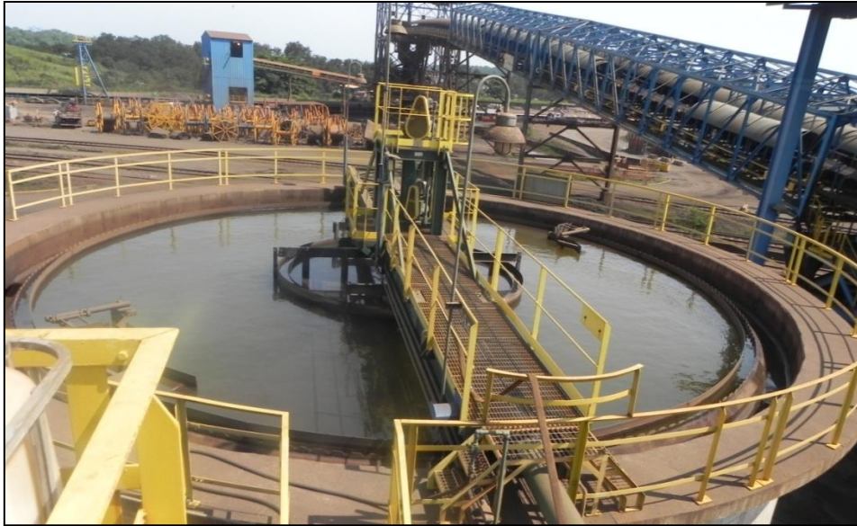
Figura 44: Clarifloculador do terminal CSN –vista superficial. (Fonte: Projeto Resíduos Portuários, 2012)
