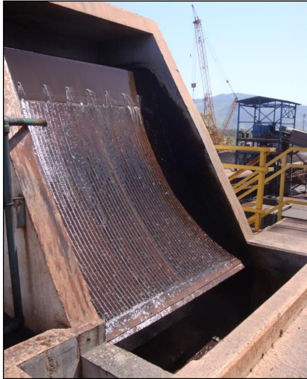
Figura 42: Peneira Estática da ETE – primeiro tratamento do efluente. (Fonte: Projeto Resíduos Portuários, 2012)
