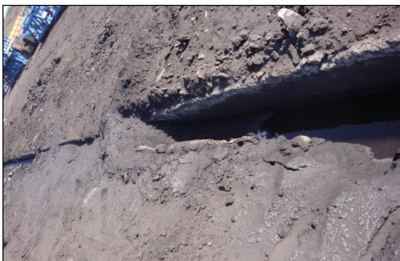
Figura 27: Acúmulo de sedimentos na canaleta de drenagem dos pátios de carvão mineral do terminal CSN. (Fonte: Projeto Resíduos Portuários, 2012)
