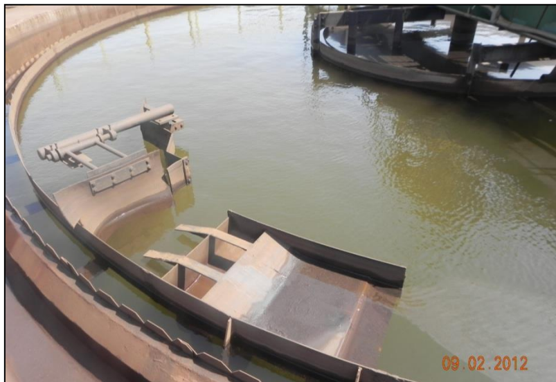
Figura 45: Estrutura de remoção para materiais flotantes. (Fonte: Projeto Resíduos Portuários, 2012)
