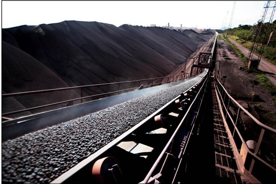
Figura 3: Transportadora de correia para minérios (Fonte: GeoLocation, 2012)
