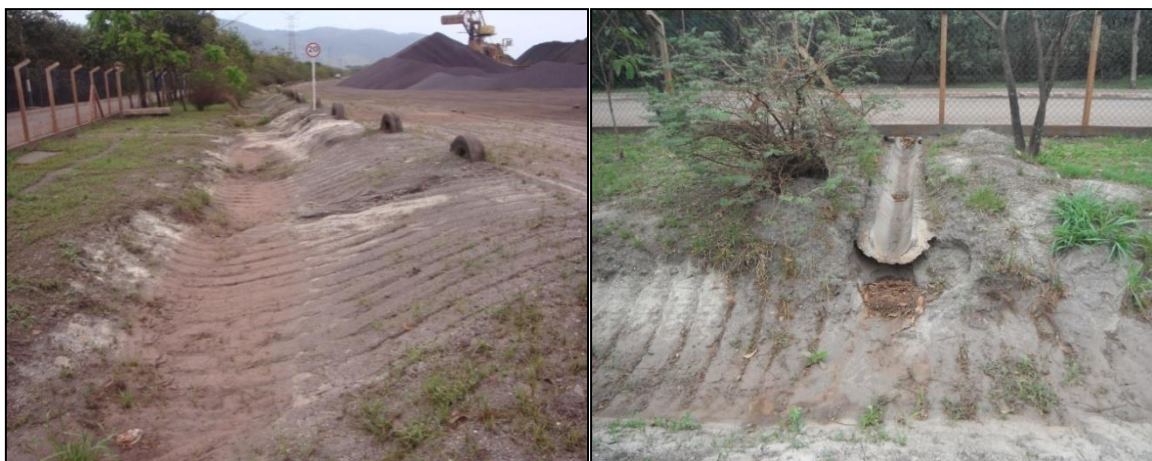
(a) Calha de Drenagem
