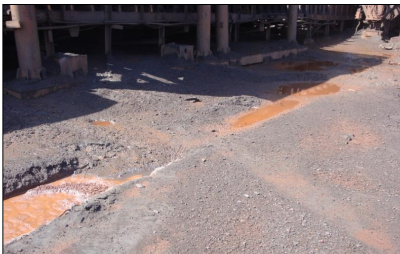
Figura 26: Acúmulo de sedimentos na canaleta de drenagem dos pátios de minério de ferro do terminal CSN. (Fonte: Projeto Resíduos Portuários, 2012)
