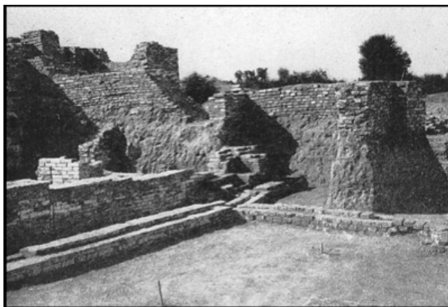
Figura 1 – Canal elevado de drenagem em Harappan
