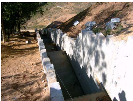
Figura 18 – Exemplo de escada hidráulica
