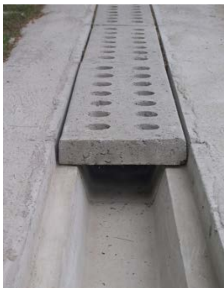
Figura 21 – Canaleta de drenagem (Fonte: Acervo do autor)
