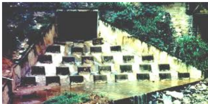
Figura 23 – Dissipador de energia
