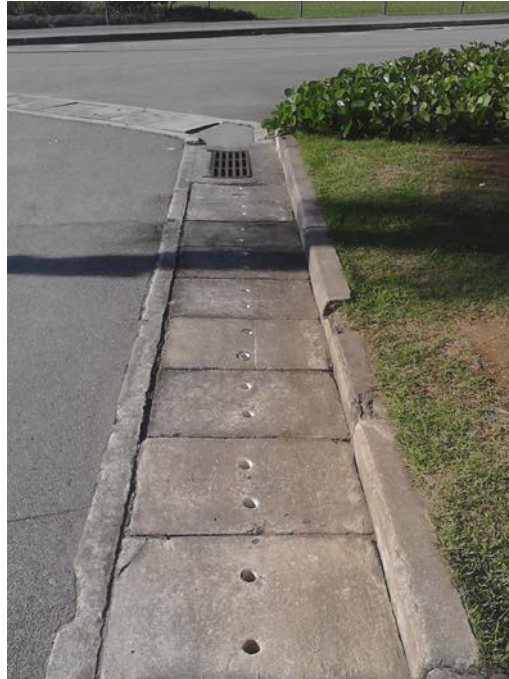
Figura 22 – Canaleta de drenagem do Parque Tecnológico da UFRJ (Fonte: Acervo do autor)
