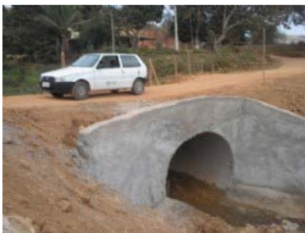
Figura 27 – Bueiro de greide (Fonte: https://www.google.com.br/search?q=bueiror+&grr=safari4f33h=43119 )
