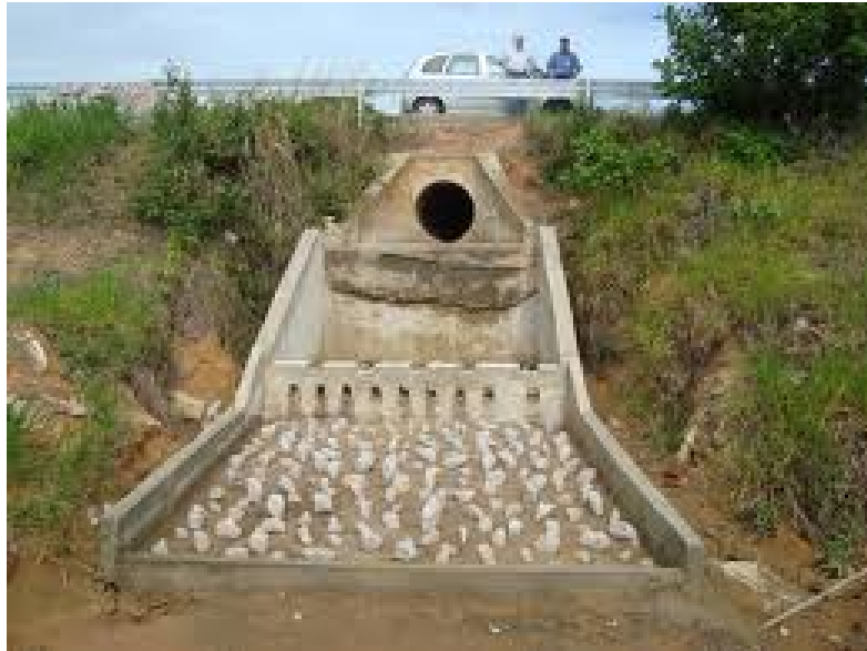
Figura 24 – Dissipador de energia
