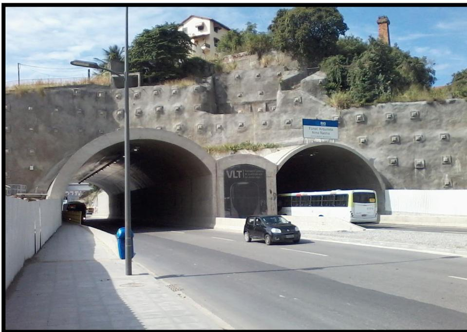
Figura 22: Foto do Túnel da Saúde, com três faixas de rolamento por sentido e 80 metros de extensão
