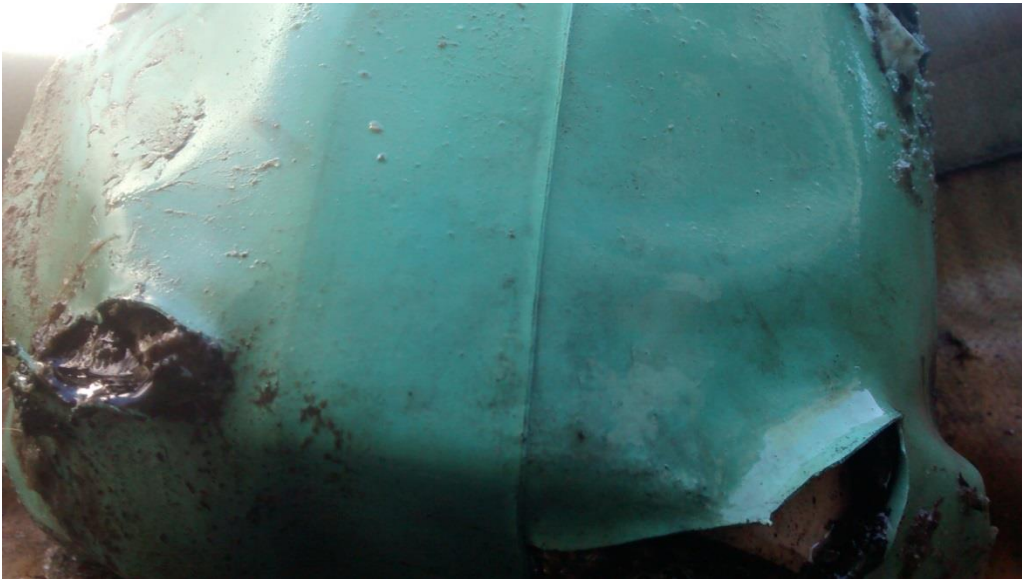
Figura 27 - Detalhe do rompimento da tubulação do reator 2
