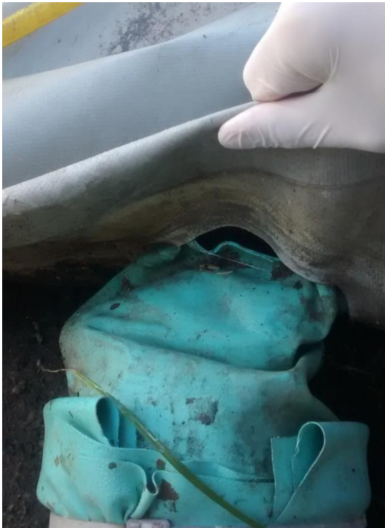
Figura 28 - Detalhe do vazamento no digestor 1
