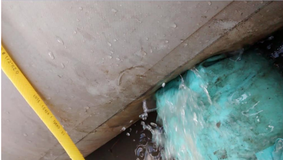
Figura 26 - Vazamento no digestor 2
