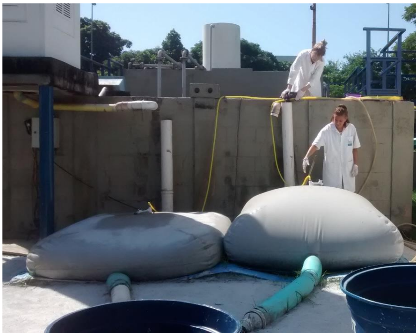
Figura 18 – Digestores têxteis em operação no CESA
