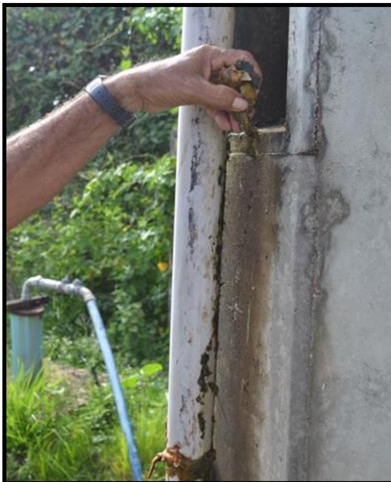
Figura 53 - Foto do lodo formado no tubo por onde passa a água captada em decorrência da presença de sais e da escola
