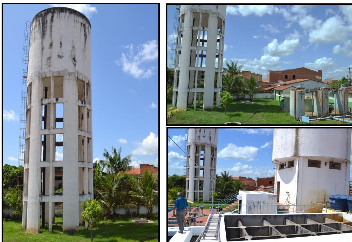
Figura 34 - Fotos do reservatório elevado do município e da ETA, com um dos operadores da estação
