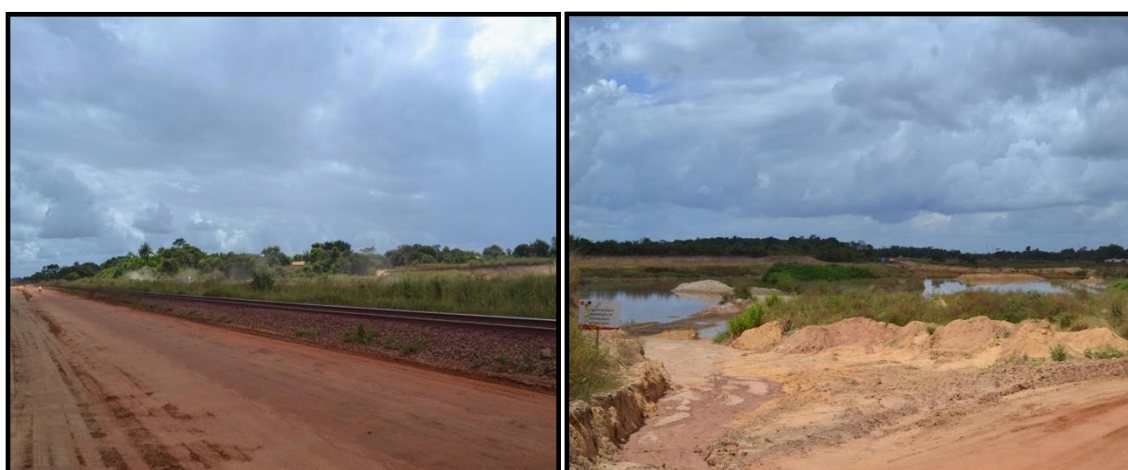
Figura 23 - Fotos de trecho da Ferrovia Carajás que passa pelo município de Arari e se encontra em obras de duplicação a cargo de empresa terceirizada
