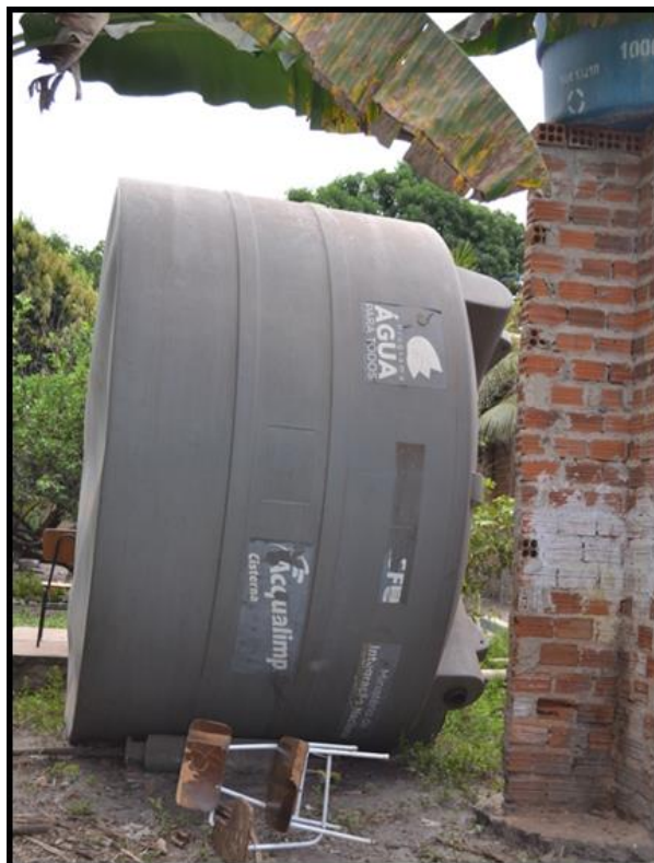
Figura 65 - Foto da caixa d'água de 16 mil litros instalada pelo P1MC que se encontra em desuso devido a defeito na bomba Fonte: Autoria própria
