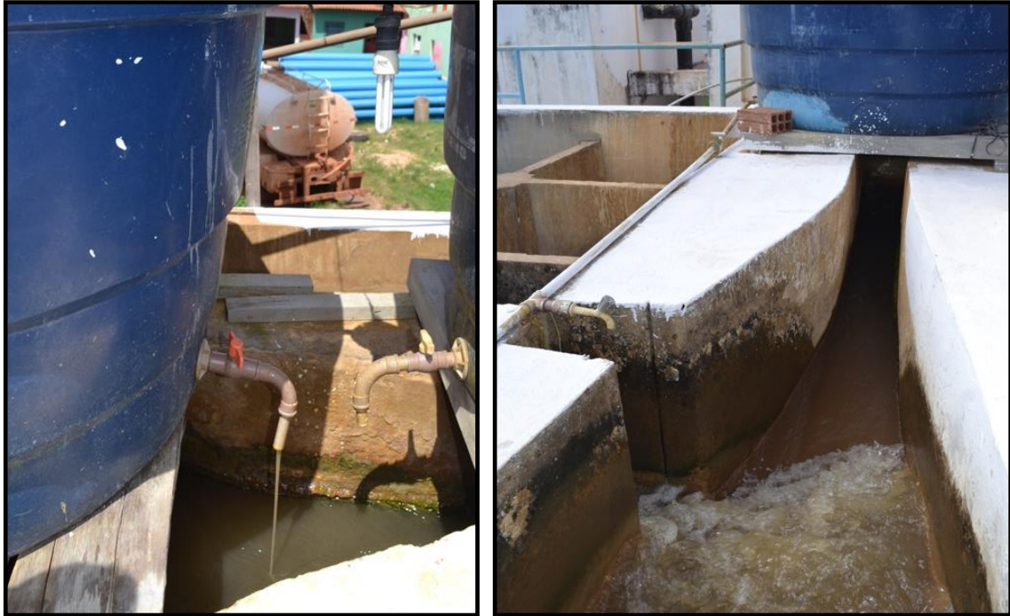
Figura 30 - Fotos da aplicação de coagulante sulfato de alumínio na água e sua passagem pela calha Parshall Fonte: Autoria própria
