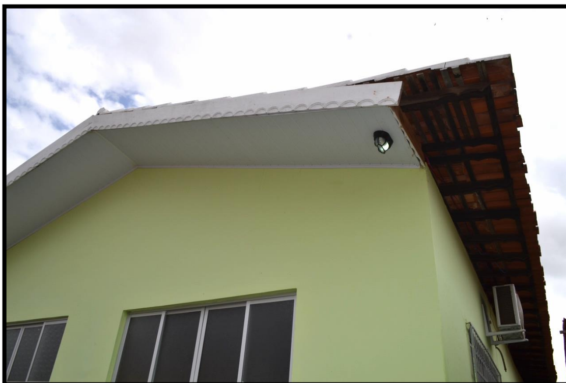
Figura 43 - Foto do telhado de telhas de barro da E.M. Professora Luiza Francelina Fonte: Autoria própria
