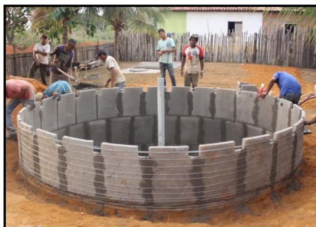
Figura 12 – Construção da cisterna de placas
