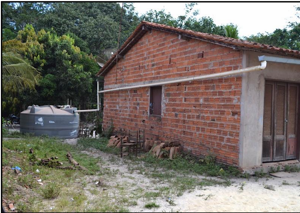
Figura 35 - Foto de casa de morador do município de Arari – MA atendido pelo P1MC, com cisterna de 16 mil litros e calhas e tubos instalados
