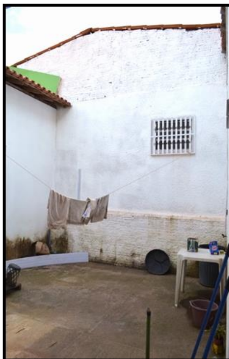
Figura 48 - Foto do vão no centro da E.M. Antônio Garcia, onde fica localizada a fossa séptica Fonte: Autoria própria
