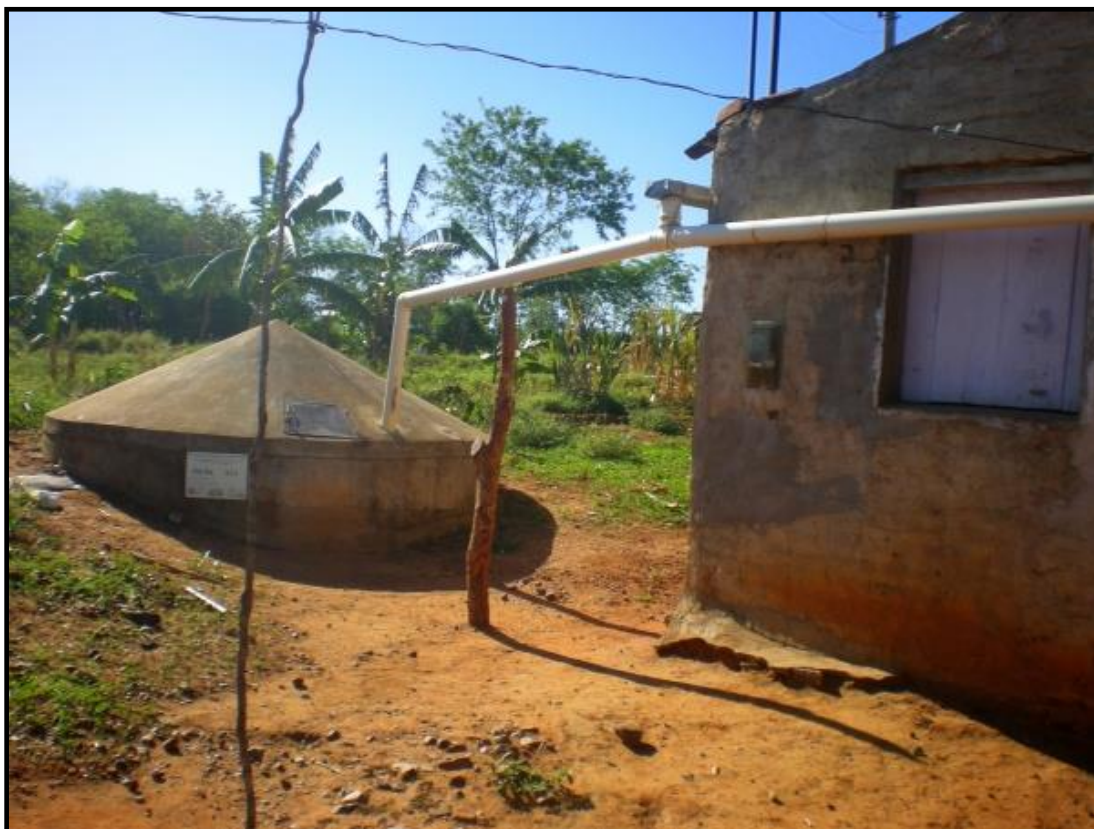
Figura 8 – Foto de suporte colocado de forma improvisada para apoiar a tubulação Fonte: Celso Calheiros
